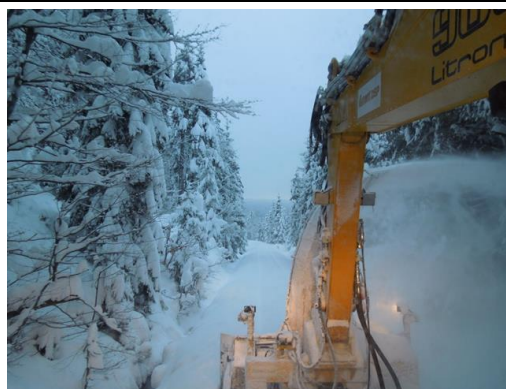
Dvoucestná sněhová fréza v činnosti na trati Harrachov - Jakuszyce. Zdroj: PDV Railway
