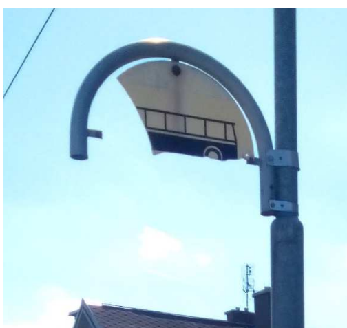
Obrázek 66: Plastové označníky nejsou dostatečně odolné - Turnov, Daliměřice, školka a Liberec, Fügnerova (výstup z tramvaj v otočce)
