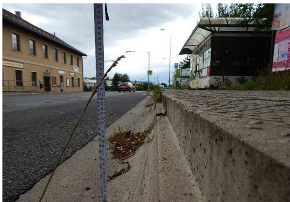
Obrázek 29: Nástupní hrana zastávky Liberec, Východní vysoká 25 cm
