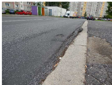
Obrázek 32: Liberec, Dobiášova – nejhlubší vyjeté koleje v LK
