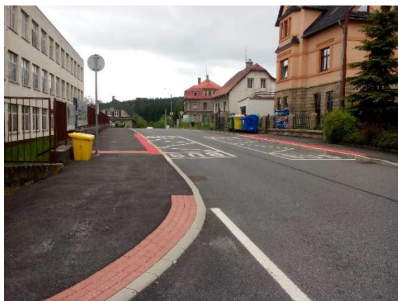
Obrázek 23: Zásada, ORNELA – živičný povrch nástupiště se zabudovanými hmatově kontrastními kostkami a lepeným barevně kontrastním pásem při hraně nástupiště
