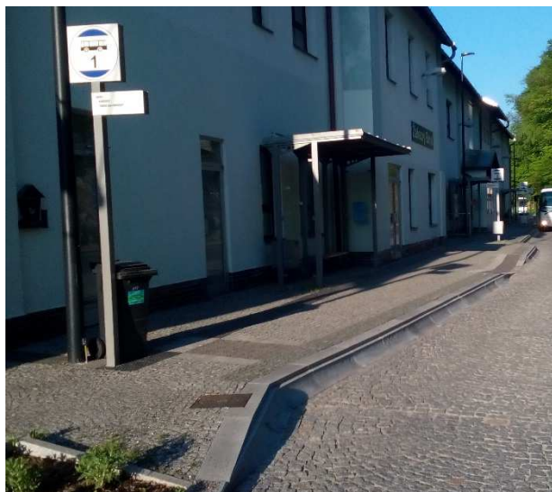
Obrázek 28: Kamenný bezbariérový obrubník v zastávce Železný Brod, Terminál u žel.st.
