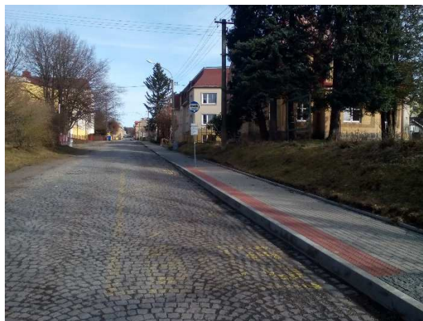
Obrázek 24: Nové Město p. Smrkem, žel.st. – barevně kontrastní pás při hraně nástupiště je nesprávně hmatově kontrastní (má být pouze barevně kontrastní)
