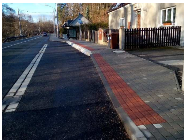
Obrázek 15: Vjezd ve vyřazovacím úseku zastávkového zálivu v zastávce Mníšek,Slovákov
