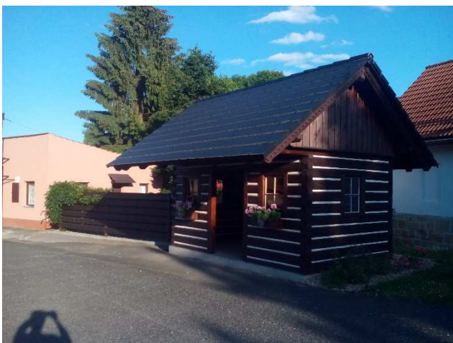
Obrázek 40: Nová roubená čekárna v zastávce Luka na Českolipsku
