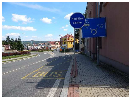
Obrázek 17: Kombinace více zpomalovacích prvků (okružní křižovatka s vjezdovým ostrůvkem a přechodem) a příkazová DZ "Neobjížděj autobus" u stanoviště zastávky Jablonec n.Nisou,,Turnovská
