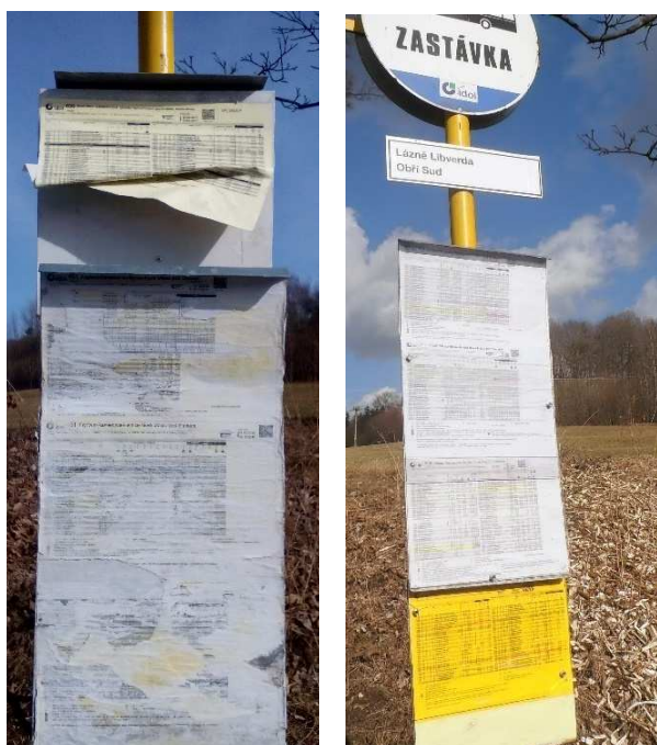
Obrázek 65: Lázně Libverda, Obří sud - větrem, deštěm poškozený výlep a následná oprava s přidáním krycím plexisklem
