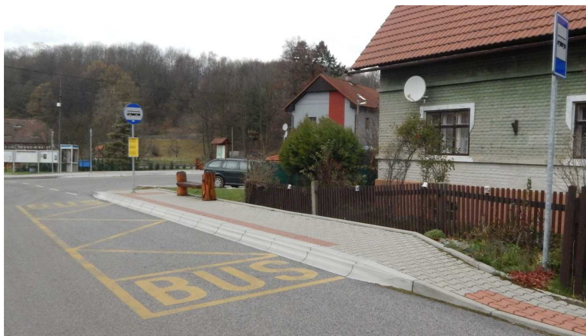
Obrázek 7: Zastávka Heřmanice - stanoviště ve směru od Dětrichova (nadbytečná V 11a, IJ 4c a navíc DZ IJ 4b má zvětšený průměr 70 cm, jako by měla být umístěna na dálnici.
