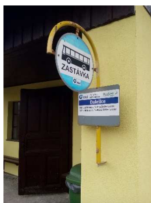
Obrázek 56: Sloupky označníku zleva: "hůl", "áčko", na čekárně, společně s jinými DZ (nevhodný případ zastávky Turnov , Kadeřavec ) a netypový sloupek DPMLJ
