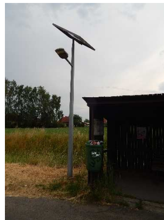
Obrázek 19: Nezávislé osvětlení s využitím solární energie v zastávce Sosnová, Ramš
