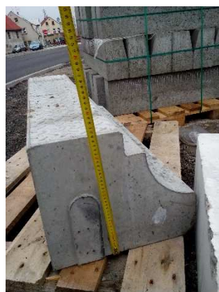
Obrázek 25: Bezbariérový obrubník (tzv. "kasselský")
