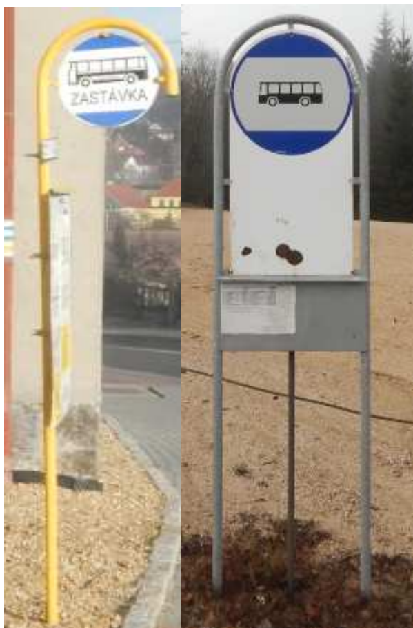
Obrázek 22: Označník zastávky na specifických konstrukcích
